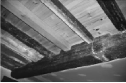
Sustitución puntual de elementos en el forjado. Rúa de Pitelos.
