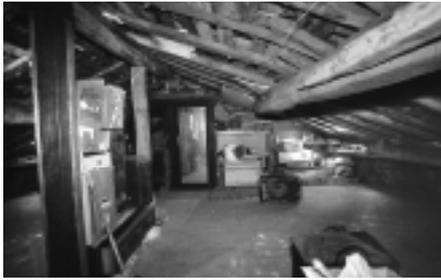
*El fallado es fundamentalmente un espacio ventilado que contribuye a aumentar el confort del edificio y a facilitar su mantenimiento. Fallado en edificio de Rúa de Belvis.*
