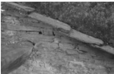
*Los botaaugas empotrados en la medianera resuelven la junta de la cubierta con el muro. Praza do Toural.*
