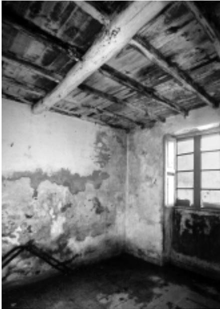
Forjado tradicional. Las vigas principales se apoyan en las medianeras y no en la fachada. Vivienda en la Rúa de Costiña do Monte.
