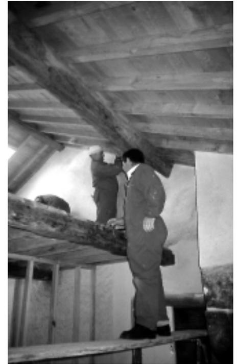
La modificación de aguas de la cubierta alteró el sistema estructural, que ahora se apoya en las medianeras formando las nuevas pendientes. Edificio en Vista Alegre.
