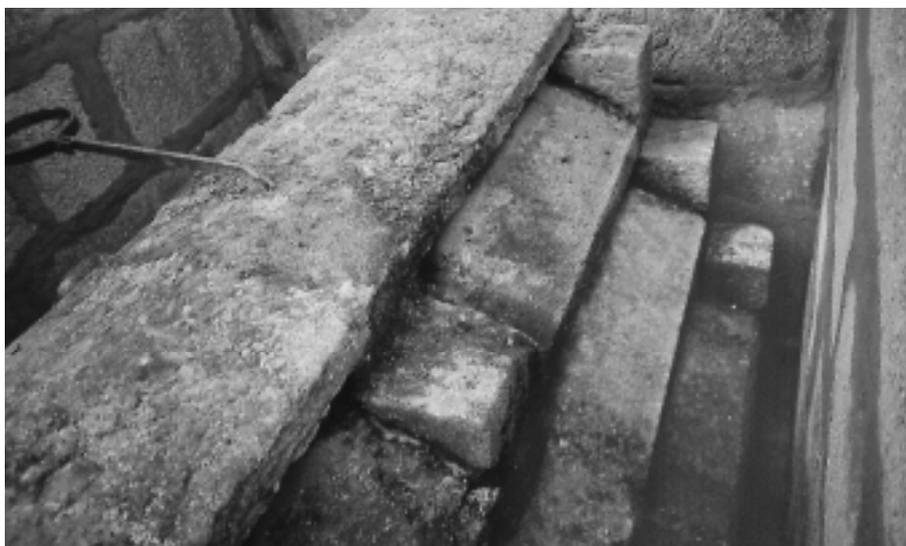
*Sección de la chimenea tradicional. El solape de las losas de piedra impide la entrada de agua al interior.*
