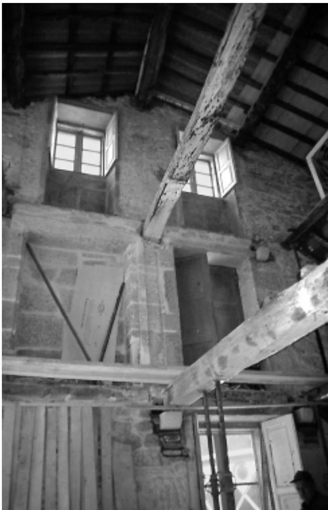
*La sustitución puntual de elementos estructurales es la menos traumática para el edificio. Estructura de vigas apoyadas en fachada. Edificio en esquina en Rúa Nova.*
