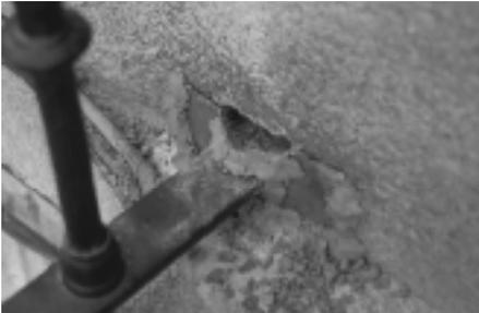
*Bebedero de arcilla para evitar el derrame del plomo fundido. Todos los elementos de hierro empotrados en la piedra deben ser recibidos y retacados con plomo para evitar roturas en la piedra debido a la oxidación del elemento empotrado.*
