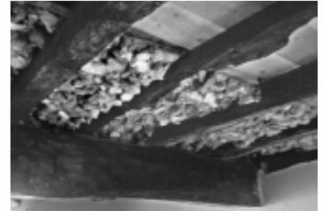
Encachado y solera de hormigón vertida directamente sobre la estructura de madera. Edificio en Rúa de Pitelos.
