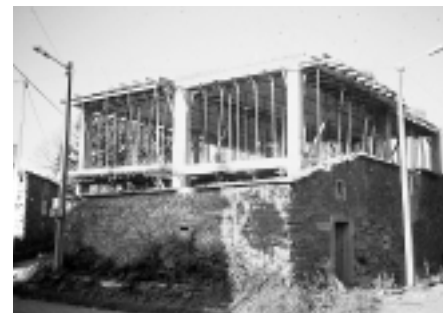
Todo o que non manexemos na lóxica das arquitecturas históricas suporá a inexorable destrución das mesmas a curto ou medio prazo. Intervención con estrutura de formigón en San Paio de Sabugueira. Setembro de 1996.
