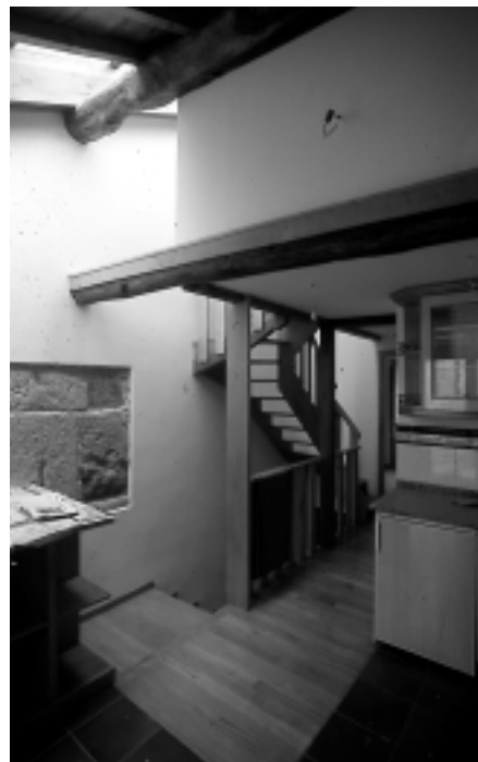
Nas intervencións consolídanse, refórzanse e reutilizan tódolos elementos que poden ser reciclados. Rehabilitación de vivenda en Rúa de Vista Alegre.
