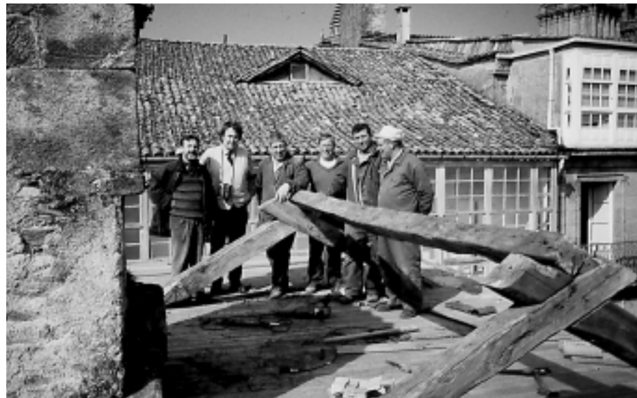
A rehabilitación é un proceso compartido e solidario. Técnicos e operarios na cuberta da Casa do Deán. Rúa do Vilar . Marzo, 1996.
