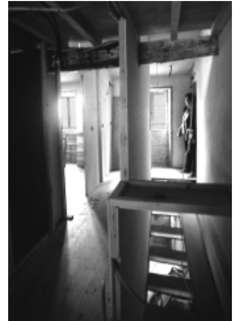
Mediante asistencias técnicas refórzase temporalmente o equipo da Oficina dedicado á supervisión e control das intervencións. Rehabilitación en Rúa de Entreríos.
