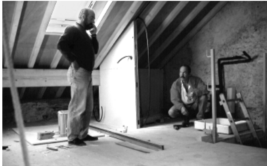
Formar unha rede de operadores da rehabilitación fomentando unha praxe constructiva axeitada para a conservación e mellora destes edificios. Obras en Rúa de Santa Cristina.
