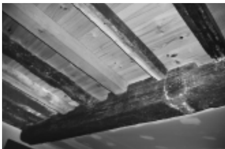
Substitución puntual de elementos no entramado de piso. Pitelos.
