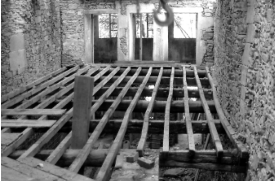
Os pontóns adóitanse apoiar na vigas por caixeado simple ou soamente apoiados. Vivenda na Rúa de San Pedro.
