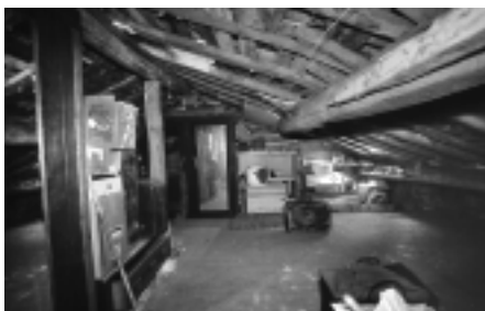
O faiado é fundamentalmente un espazo ventilado que contribúe a aumenta-lo confort do edificio e a facilita-lo seu mantemento. Faiado en edificio da Rúa de Belvis.
