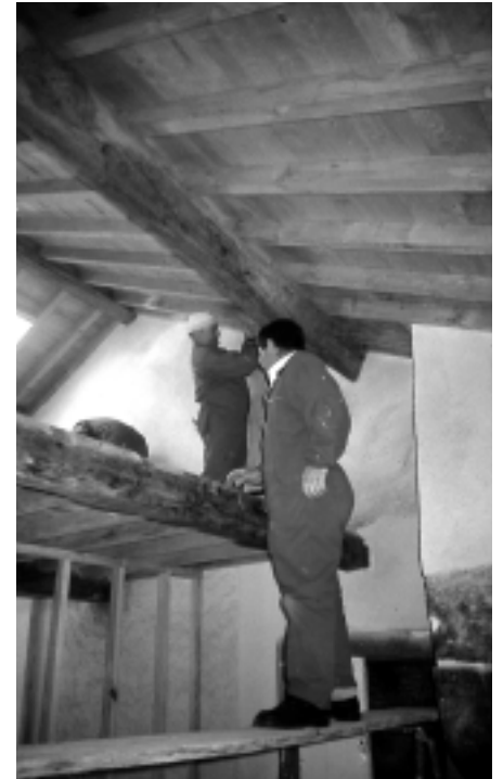
A modificação de águas da cobertura alterou o sistema estrutural, que agora se apoia nas medianeiras formando as novas pendentes. Edifício em Vista Alegre.
