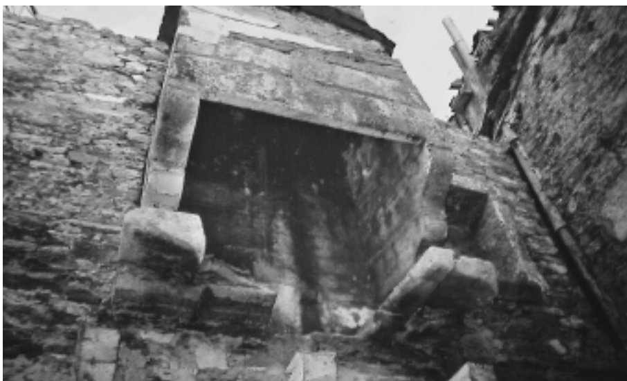
Lareira empotrada no muro medianeiro. Rúa de San Pedro.
