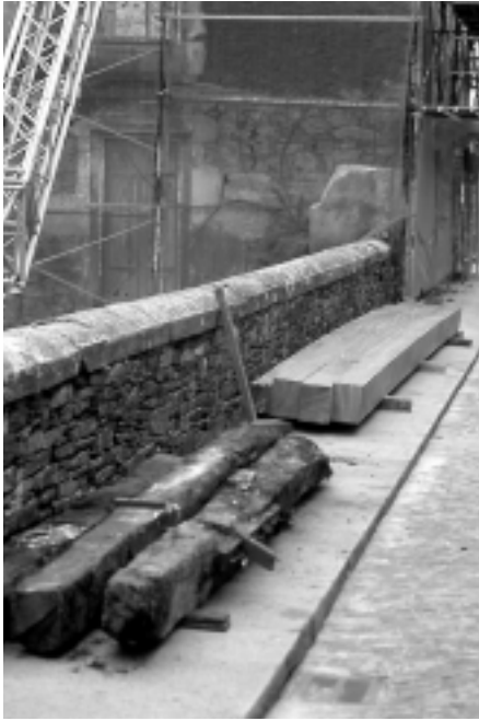
O mellor reciclado de materiais será sempre a súa reutilización. Substitución de vigas na Rúa dos Loureiros.
