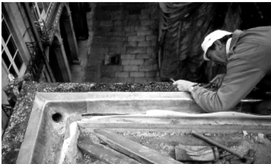
Reparación de canal enchumbado na cornixa da Casa do Deán. Rúa do Vilar.
