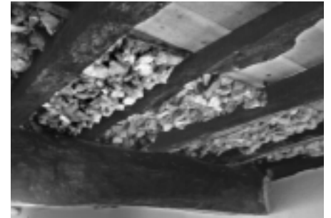
Encachado e soleira de formigón vertida directamente sobre a estrutura de madeira. Edificio en Rúa de Pitelos.
