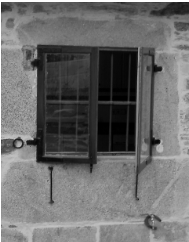
A pedra do peitoril onde se apoian as xambas debe ter unha sección importante para evita-la súa rotura pola compresión destas. Rúa de Vista Alegre.
