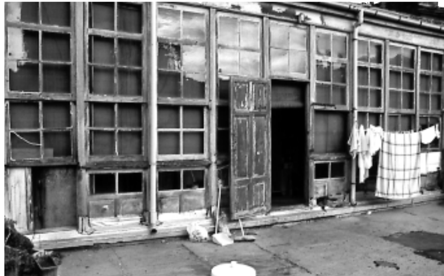
O 38,5% dos edificios atopábanse en 1990 en estado regular de conservación. Azotea na Rúa do Vilar.
