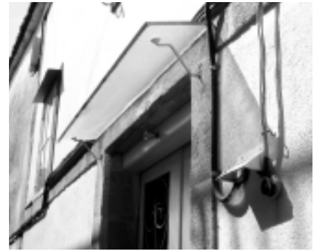
Protección contra a chuvia en porta de acceso a edificio. Rúa Nova.
