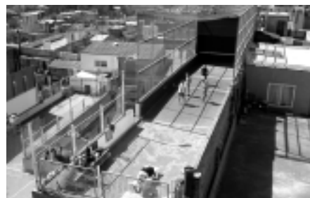
Onde o tempo –e a normativa- o permiten, as cubertas poden acoller diferentes usos. Frontón e solarium nunha azotea. Proximidade do Convent des Angels. Barcelona.
