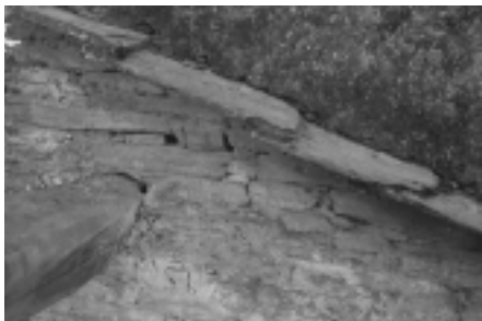
Os verteaugas empotrados na medianeira resolven a xunta da cuberta co muro. Praza do Toural.
