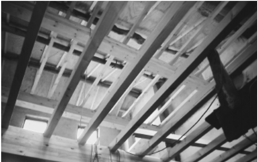
Existen solucións fiables para o illamento acústico dos entramados de madeira. Estructura de forxado en edificio de Campo de Santo Antonio
