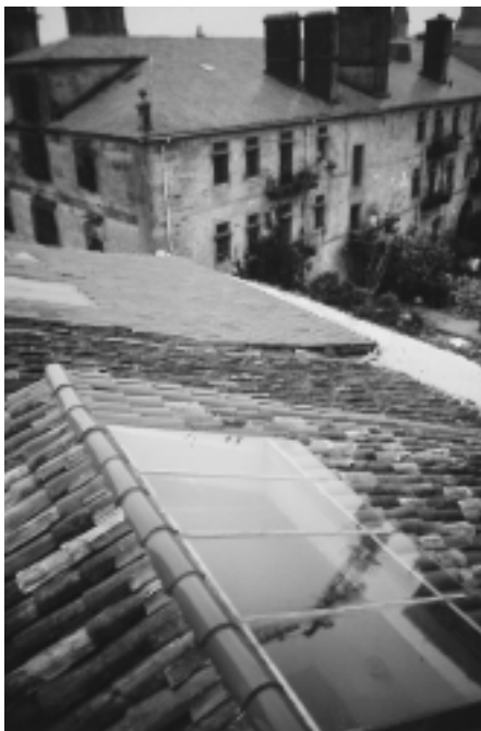
Os tradicionais lucernarios poden orienta-lo emprego de imaxinativas solucións de iluminación nas plantas superiores. Lucernario na Rúa da Conga.
