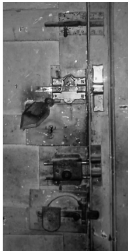
Interior da porta de entrada á Casa do Deán, na Rúa do Vilar. Pechaduras colocadas ó longo da vida do edificio.
