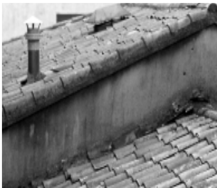
Remate de cuberta con tellas por eliminación do topete de pedra. Rúa das Carretas.
