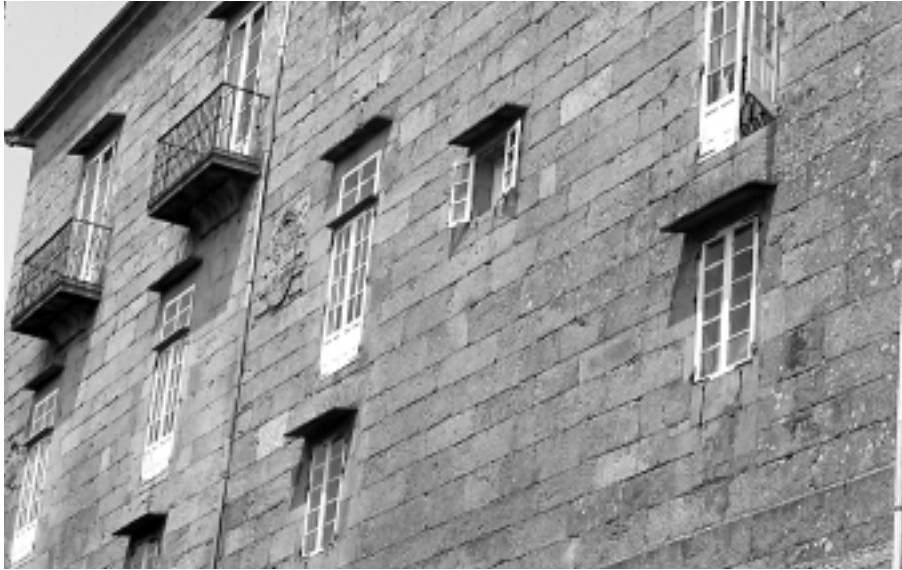
Os aleiros en Santiago son curtos e os verteaugas protexen as fiestras enrasadas da auga que desliza pola fachada. Pazo de Xelmírez.
