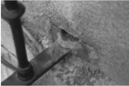
Bebedeiro de arcilla para evita-lo derrame do chumbo fundido. Tódolos elementos de ferro empotrados na pedra deben ser recibidos e retacados con chumbo para evitar roturas na pedra debido á oxidación do elemento empotrado.
