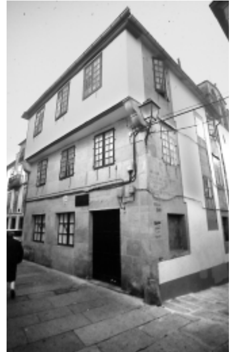
Edificio con fachada de entramado de madeira na planta superior. Rúa da Troia.
