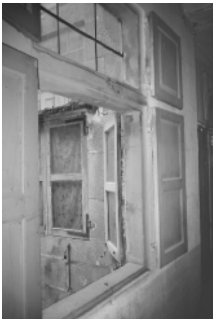
Solución tradicional para a colocación da contraventá opaca ó interior. Casa do Deán. Rúa do Vilar.
