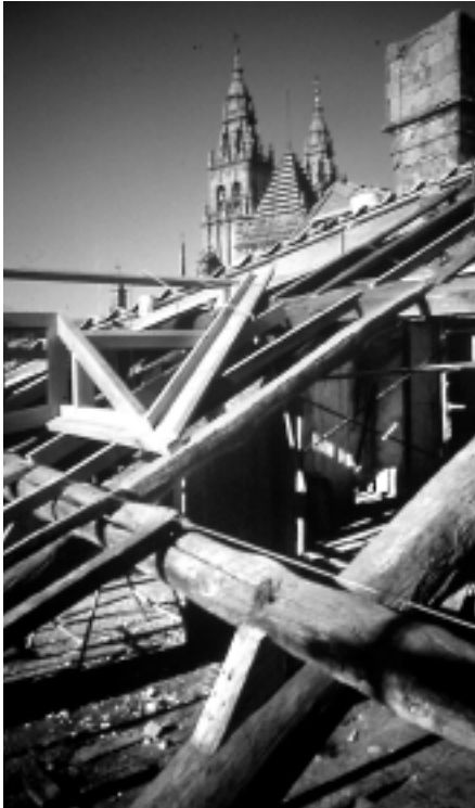
Reparación de cuberta na Casa do Deán. Vilar.
