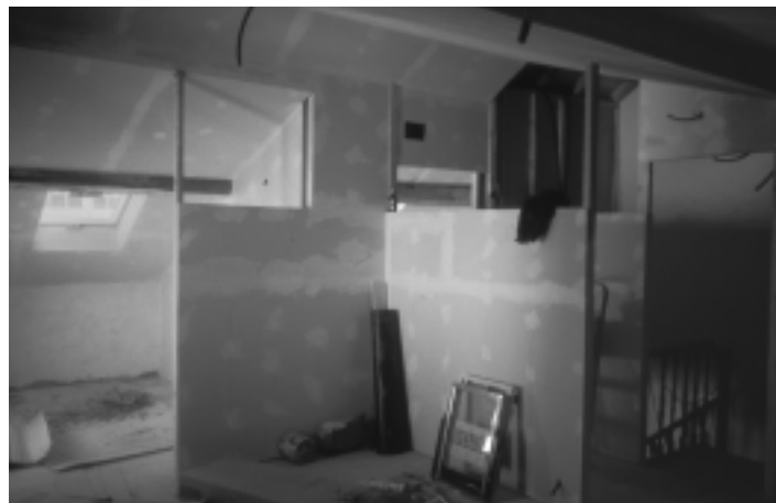
Rehabilitación con sistemas de tabiquería en seco. Fonte de Santo Antonio.
