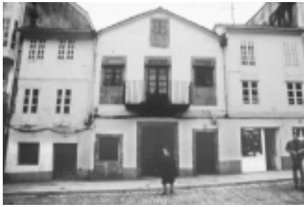
Edificación coa cuberta orixinal a dúas augas e testeiro cara a rúa. Rúa de San Pedro.
