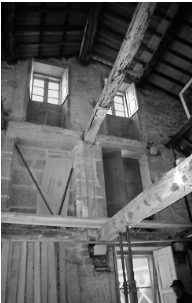
A substitución puntual de elementos estruturais é a menos traumática para o edificio. Estructura de traves apoiadas na fachada. Edificio en esquina en Rúa Nova.
