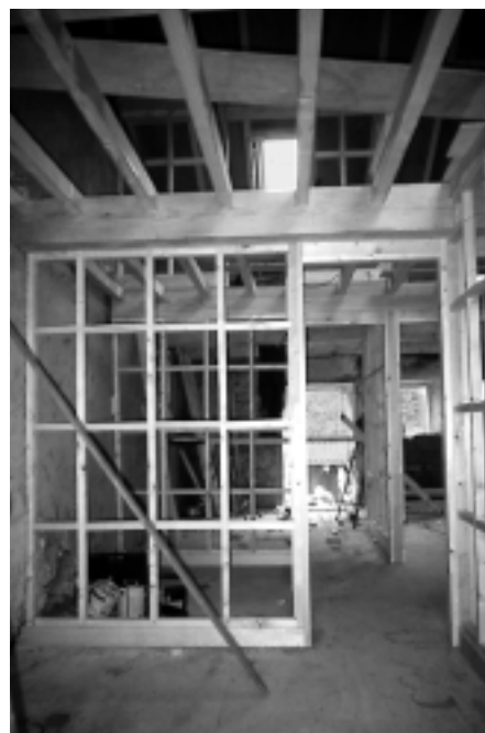
Estructura e bastidores para instalación de tabiquería en seco. Rúa de Bonaval.
