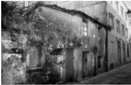
Edificio unifamiliar. Rúa dos Lagartos.
