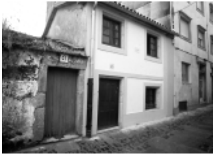
Edificio unifamiliar rehabilitado. Rúa dos Lagartos.
