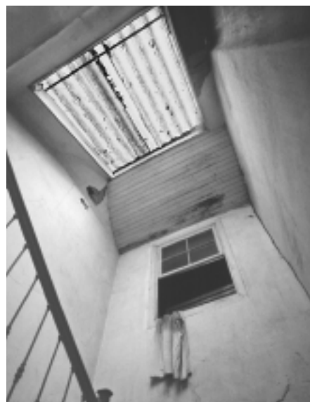
A substitución do lucernario tradicional por solucións de aparente menor mantemento, como o uralux, empobreceu o carácter de patios de luces e núcleos de escaleira. Edificio na Rúa das Carretas.
