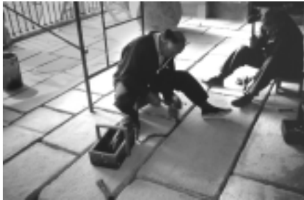
Impermeabilización de terraza coa técnica de calafateo empregada sobre as embarcacións da Ría de Arousa. Casa do Deán. Rúa do Vilar.
