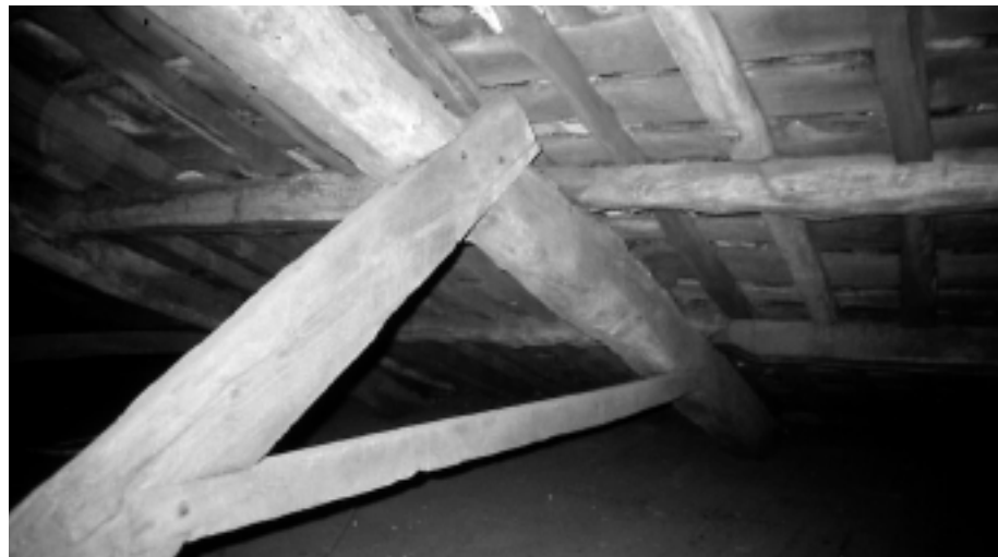
Estructura tradicional de cuberta. Edificio na Praza do Toural.
