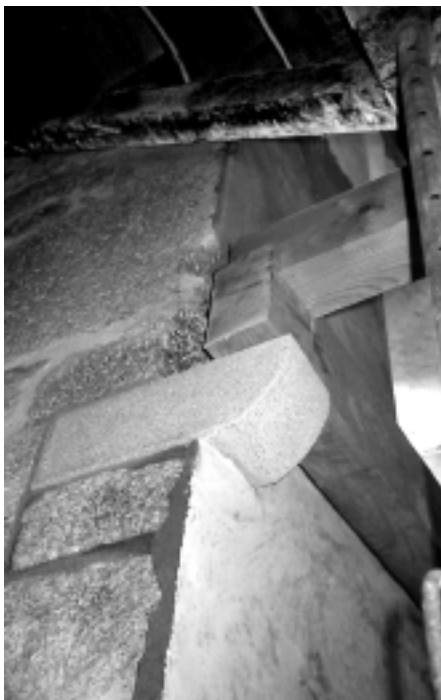
Canzorro de pedra para apoio de durminte. Rúa Nova.
