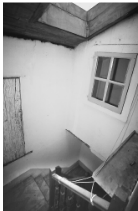
Ventilación e iluminación de cuartos á escaleira, forzada polo incremento do fondo construído ou pola ausencia de patio de luces. Edificio na Rúa de San Pedro.
