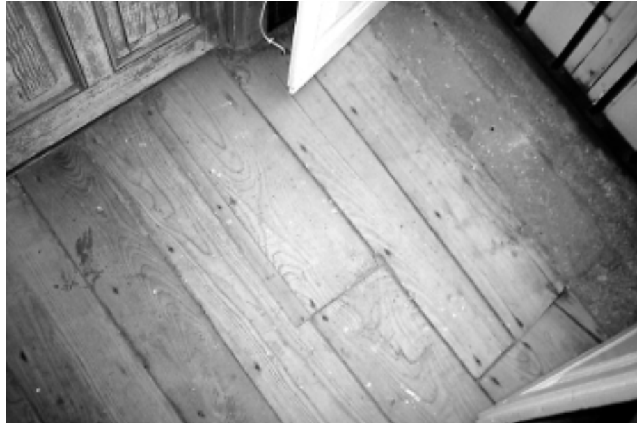
Os pavimentos, cravados directamente ós pontóns, contribúen á estabilidade do entramado. Vivenda na Rúa dos Bautizados.
