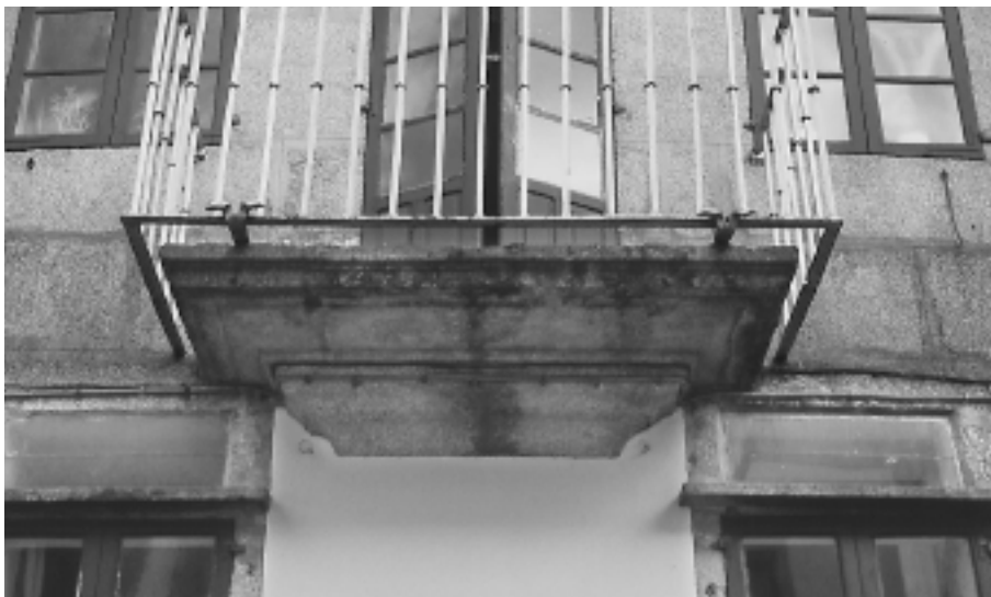
Balcón sobre ménsula en Rúa das Hortas.
