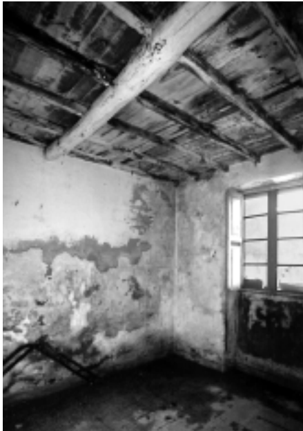
Entramado tradicional. As vigas principais apóianse nas medianeiras e non na fachada. Vivenda na Rúa da Costiña do Monte.
