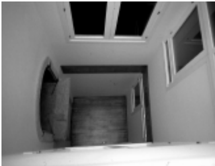
A creación dun patio de luces, aínda que sexa pequeno, mellorará as condicións de habitabilidade das vivendas. Patio de ventilación en edificio da Rúa do Franco.
