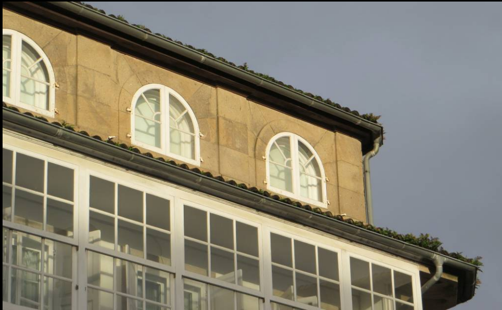
muro de perpiaño
