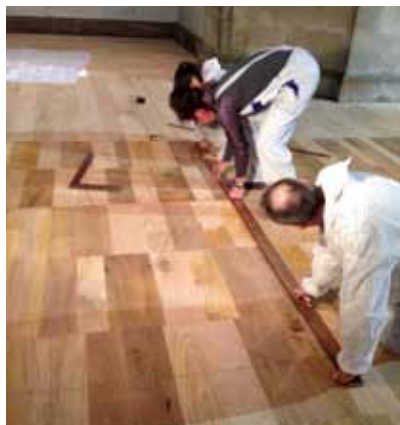
Los técnicos del Consorcio dibujando las monteas sobre la tarima de madera
