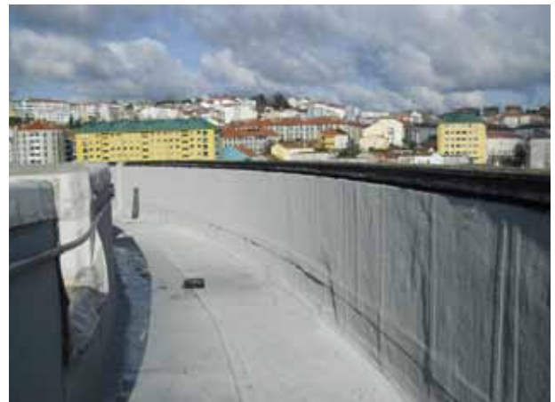
La actuación en el Multisusos de Sar se centró en eliminar la entrada pluviales al interior del edificio
