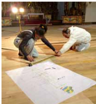
Los técnicos del Consorcio dibujando las monteas sobre la tarima de madera
