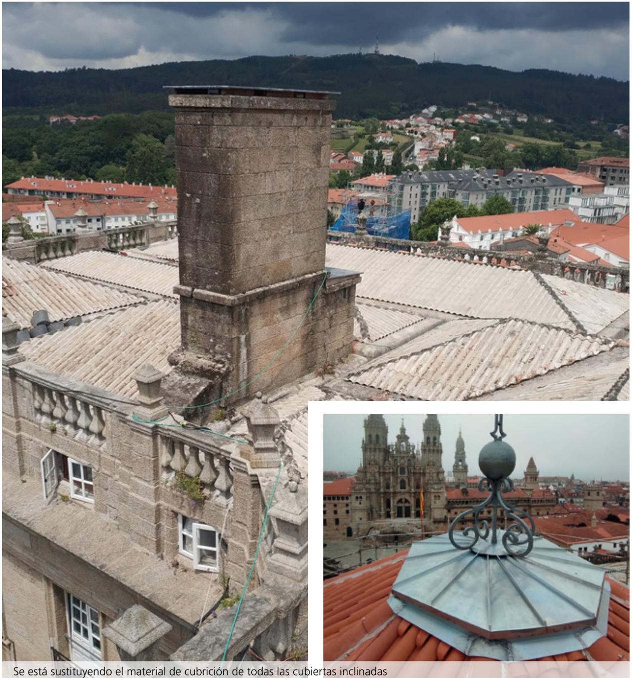
Se está sustituyendo el material de cubrición de todas las cubiertas inclinadas
