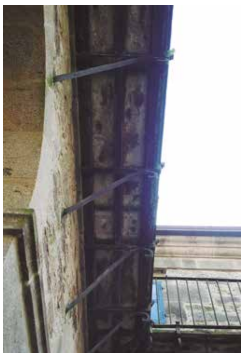
El balcón del claustro del convento del Carmen tenía su estructura portante muy oxidada
