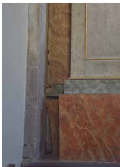
El conjunto estaba muy afectado por el ataque de xilófagos y por podredumbre
