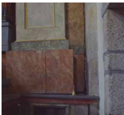
El conjunto estaba muy afectado por el ataque de xilófagos y por podredumbre
