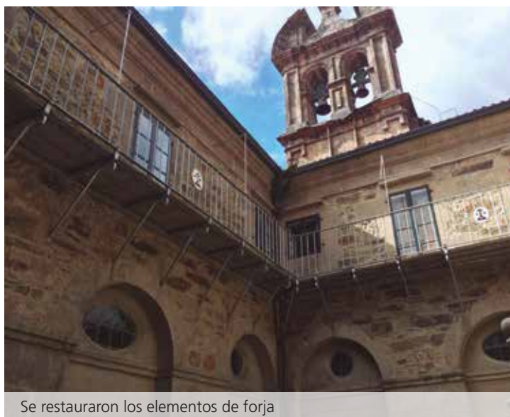
El balcón del claustro del convento del Carmen tenía su estructura portante muy oxidada
