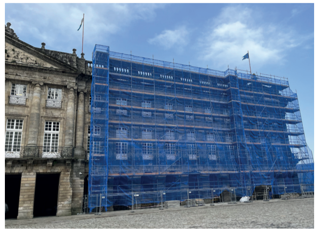
Máis información: http://www.consorciodesantiago.org/gl/novas/comezan-obras-de-conservacion-e-mellora-de-eficiencia-enerxica-da-fachada-leste-do-pazo-de
