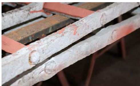
En caso de que existan roturas o gran pérdida de material, se pueden efectuar soldaduras con electrodo (soldadura por arco) de altas prestaciones, aportando acero al carbono. La calidad del electrodo es importante en este caso, para reponer o aportar elementos necesarios a la forja. Para dar una calidad similar a la del hierro forjado, es bueno forjar la soldadura.
