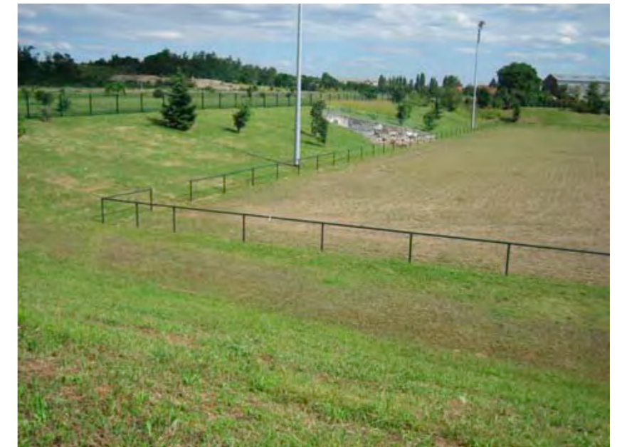
Campo de fútbol integrado en un depósito de detención e infiltración, Lyon, Francia
