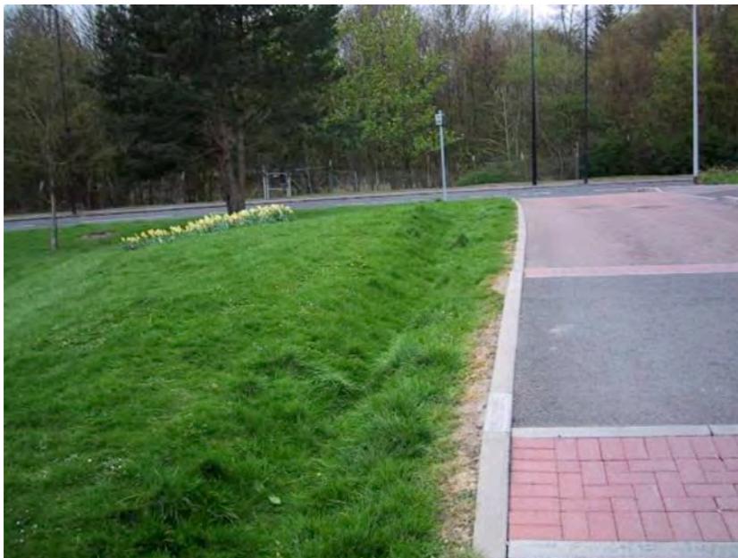
Cunetas verdes como drenaje lateral de calzada (Dundee, Escocia 2007)
