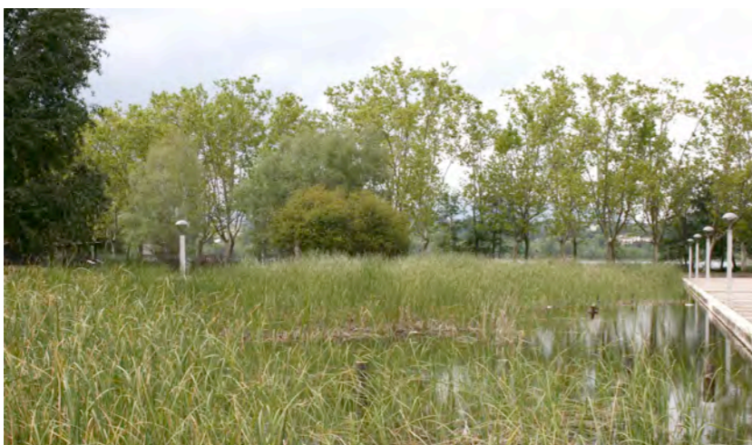
Balsa de laminación inundada y con vegetación acuática. Parque de la Draga de Banyoles, P. Eisenma
