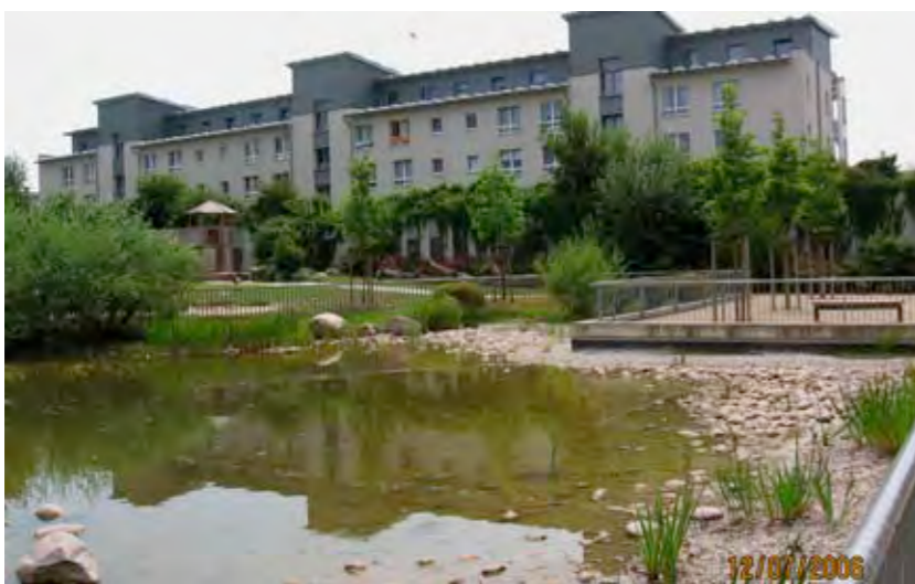
Balsa de infiltración del agua captada en cubiertas y calles en el barrio de Kronsberg, Hannover ("Hannover Kronsberg - The Rainwater Management Concept" de Atelier 9).
