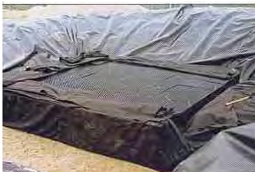
Ejemplos de ATLANTIS para tratamiento y almacenaje del agua de escorrentía en espacios verdes mediante depósitos enterrados.
