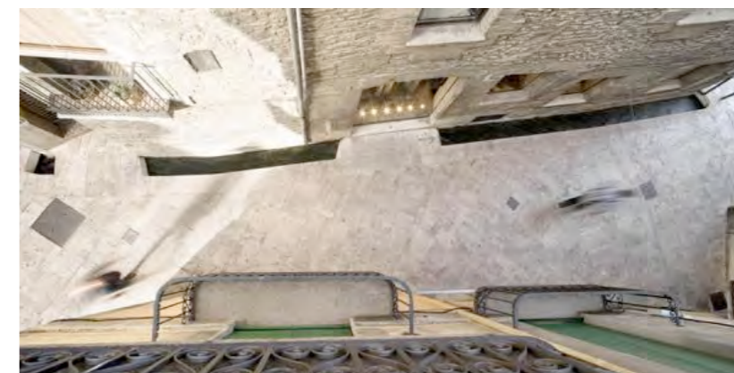
Canales de recogida de la escorrentía de agua de lluvia en la reforma del centro histórico de Banyoles (Girona). Josep Miàs arquitecto.
