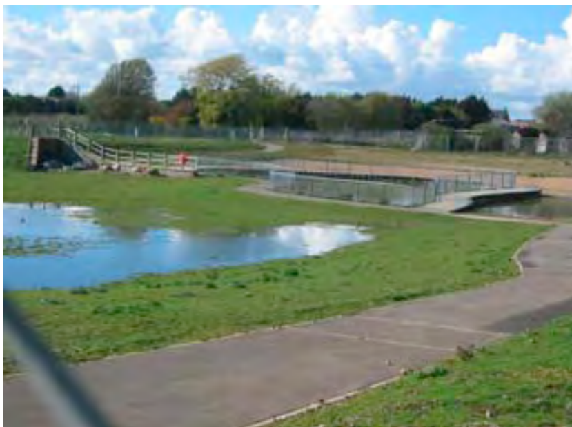
Depósito o estanque de infiltración (ejemplo incluido en el artículo "Los S.U.D.S.: una alternativa a la gestión del agua de lluvia" de la U.P. de Valencia)
