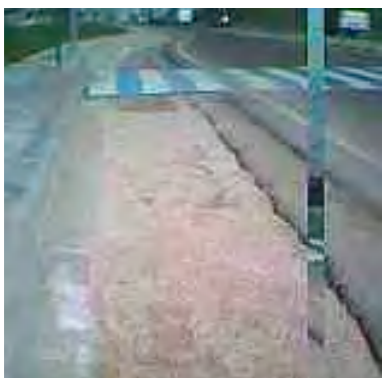
Construcción de zanja de infiltración con celdas modulares de drenaje "Atlantis"
