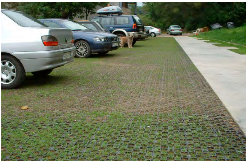
Pavimento permeable Atlantis en aparcamiento de San Sebastián
