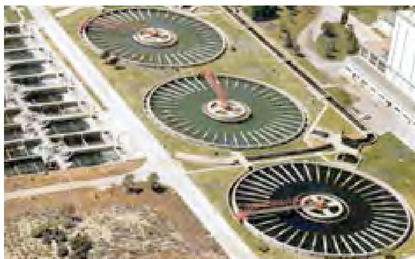
Lodos de EDAR
