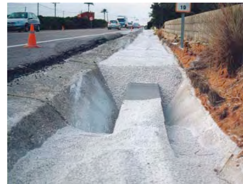
Dren filtrante. Actuación de nivelación de cuneta en de la carretera CV-50 en el término de Alzira, Valencia.
