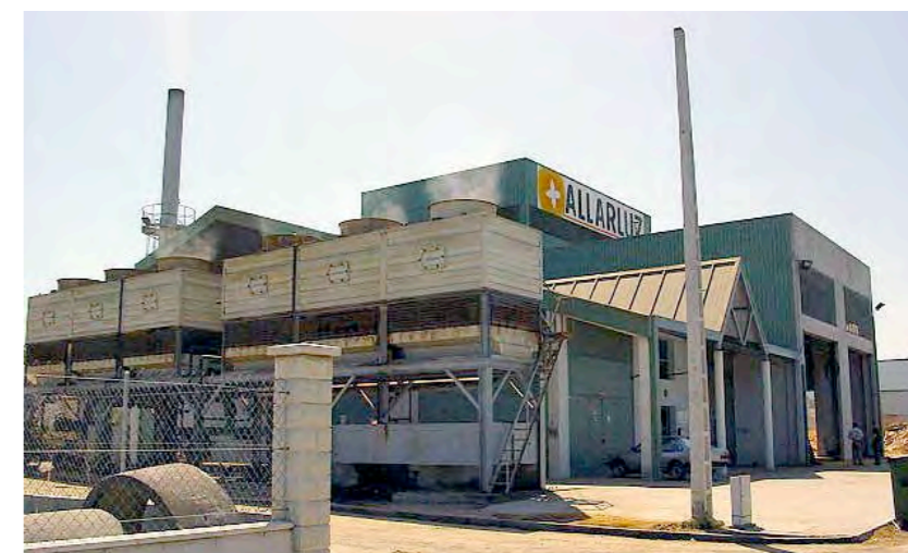
Central de Biomasa en Cogeneración Allariz de Allariz, Galicia
