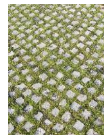
FILTRACIÓN Y INFILTRACIÓN
