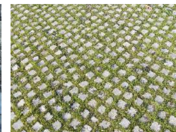
ABSORCIÓN AGUAS PLUVIALES
