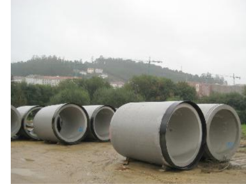
Obras del colector
