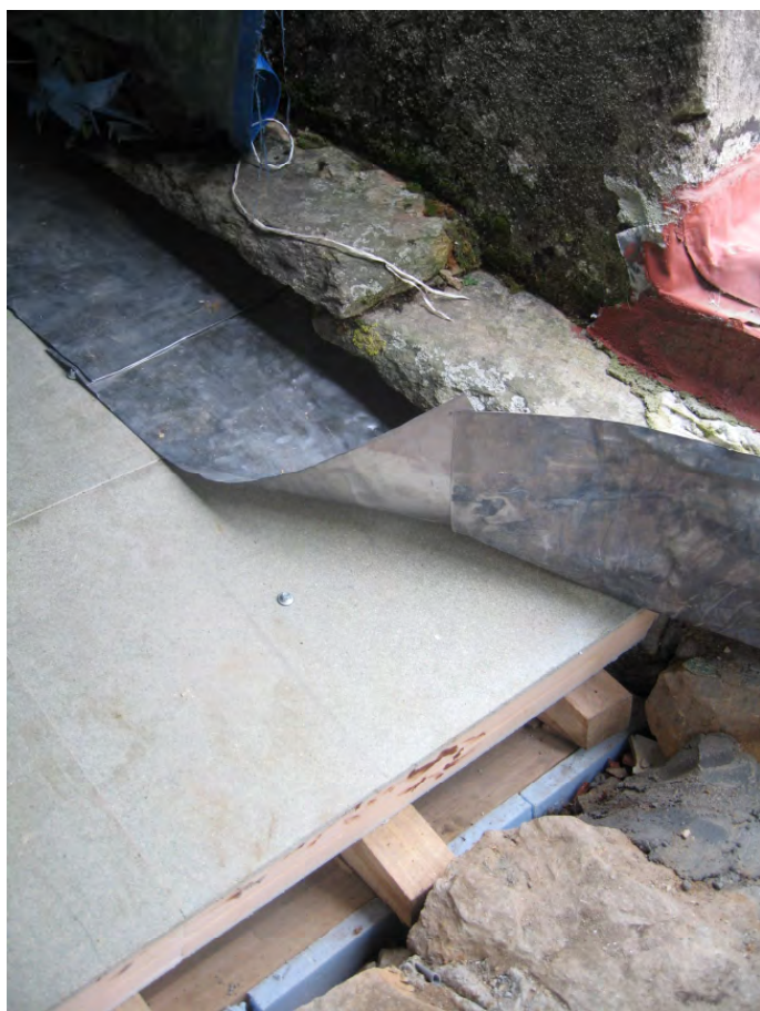
detalle de la colocación del plomo bajo el topete existente
