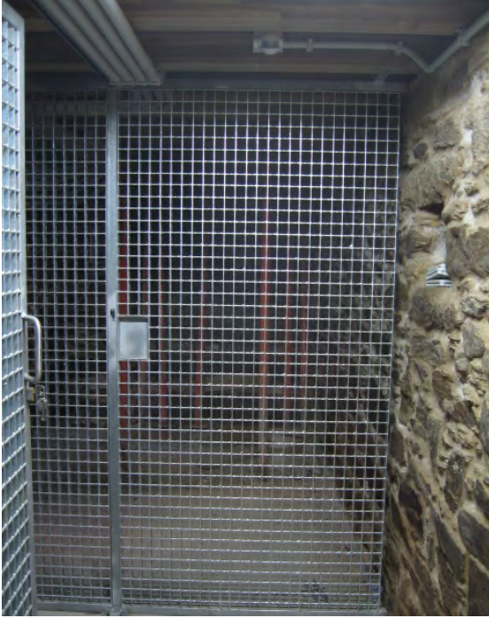
tabiquería interior de los trasteros de "tramex"
