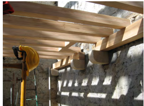
el apoyo de los puntones en la medianera se realiza mediante una pieza que apoya en canzorros de piedra
