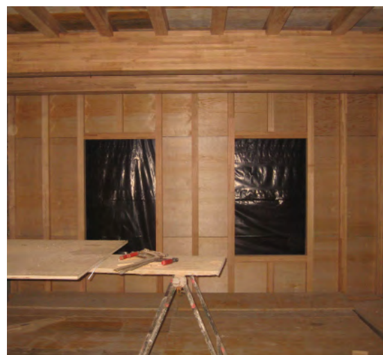
la subestructura de la fachada ligera
