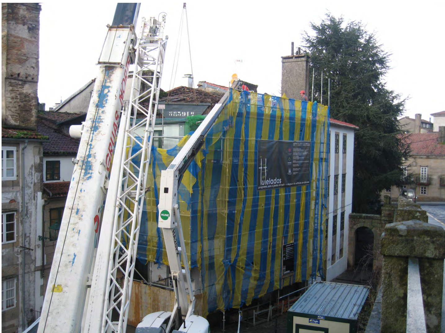
la demolición de la cubierta resultó especialmente compleja
