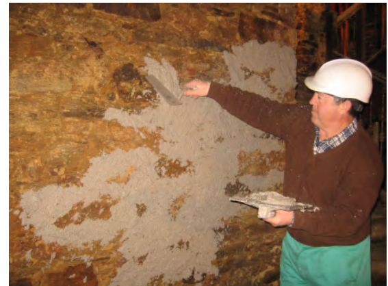
el revoco interior cubre parcialmente los cachotes de piedra
