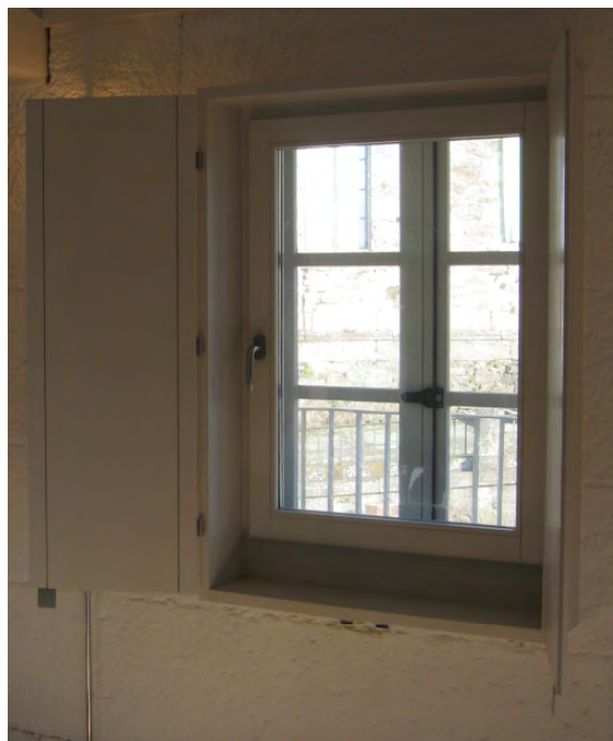
ventana oscilobatiente interior con marco perimetral para recibir contraventanas
