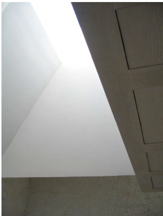
el nuevo lucernario sobre las escaleras devolvió la luz al interior del edificio como una metáfora de todo el proceso de rehabilitación
