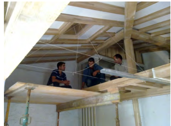
replanteo del lucernario de la caja de escaleras
