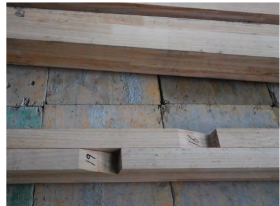
las piezas de la estructura se mecanizan mediante maquinaria con control numérico y se envían a la obra listas para su colocación
