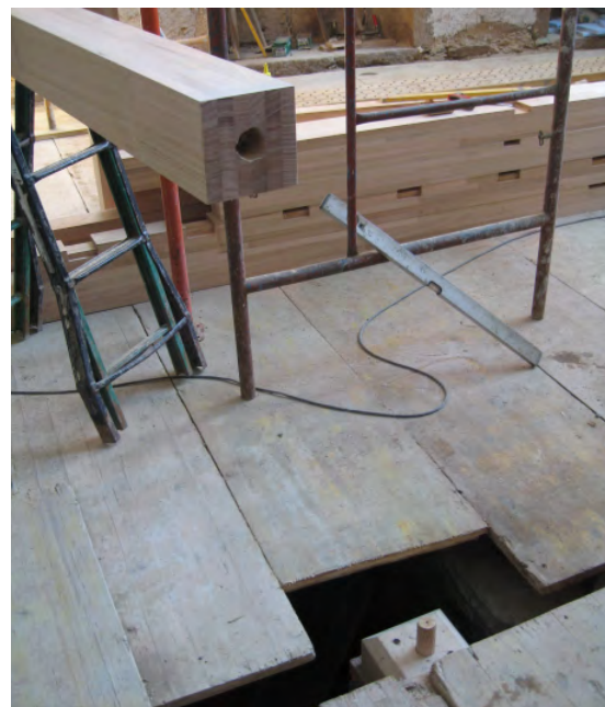
detalle de arranque de pilar de madera en pilastra de ladrillo del sótano
