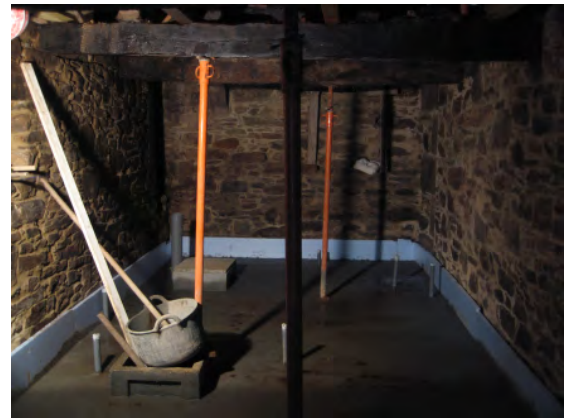
el perímetro del forjado ventilado permite la ventilación y evita que el hormigón se adhiera a los muros de piedra
