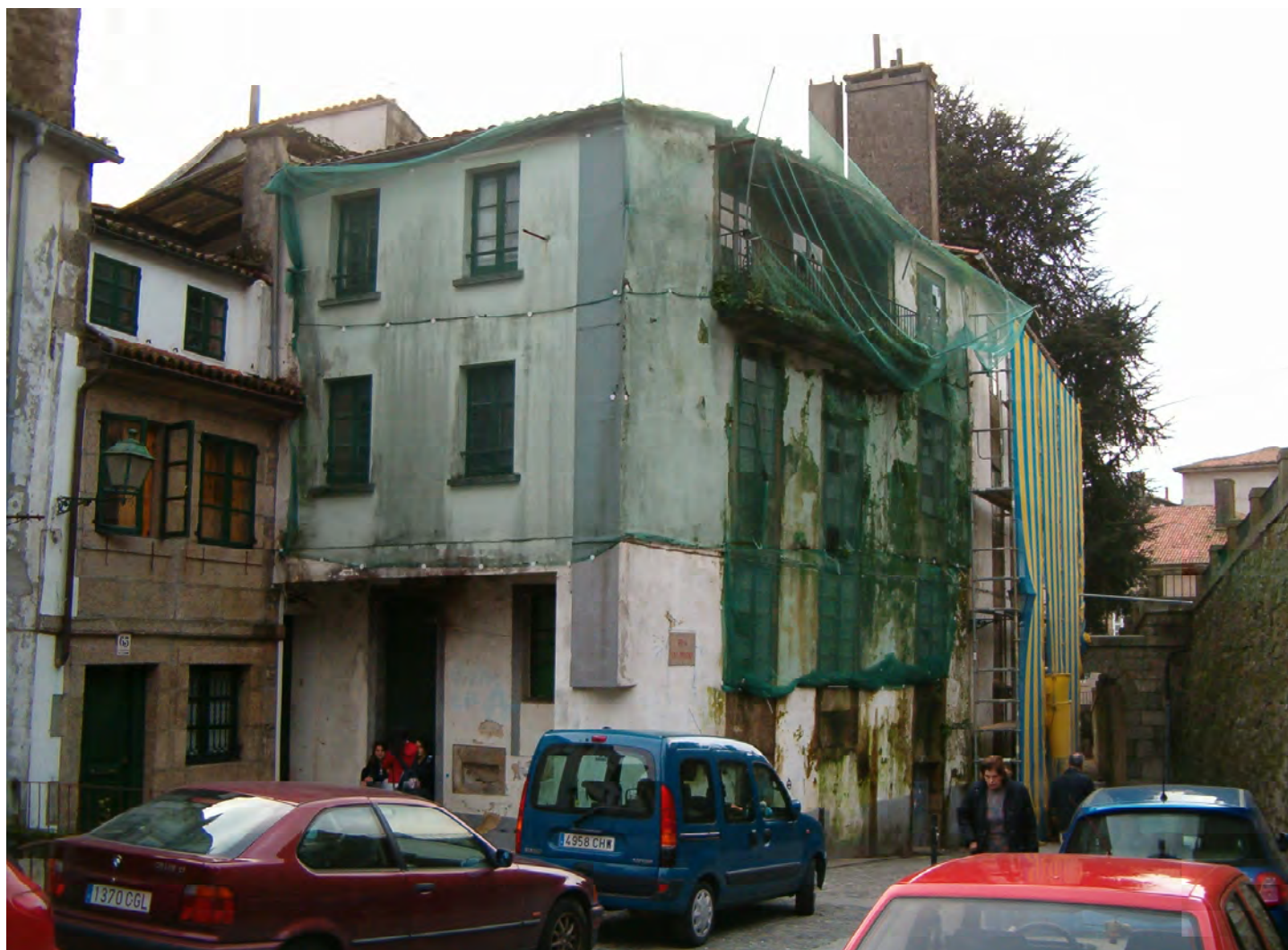
estado general del inmueble
