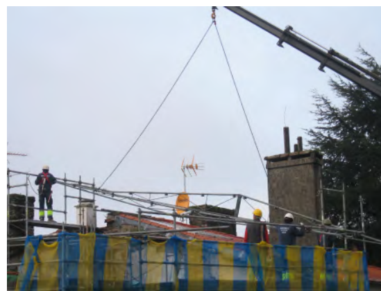
montaje de la cubierta provisional
