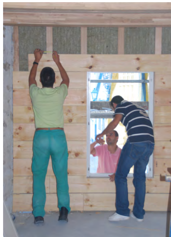
ejecución del acabado interior de tabla
