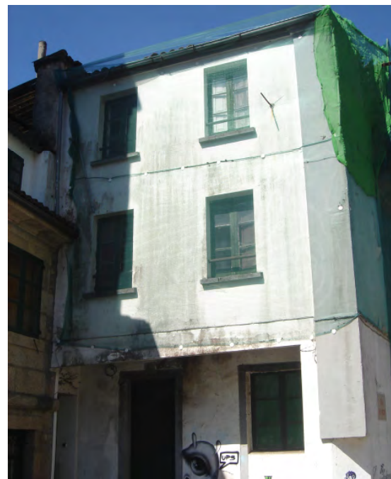
esta fachada en la planta primera y segunda estaba hecha con ladrillo y redondos de acero
