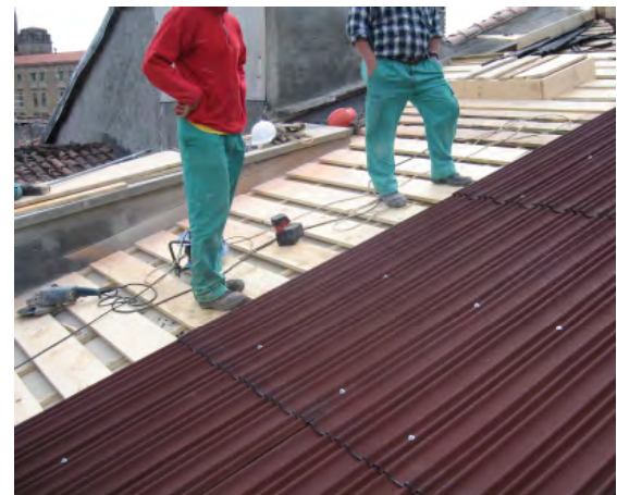
vista de las diferentes capas que integran la cubierta
