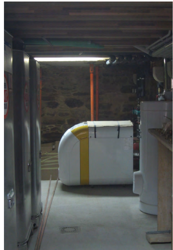
la sala de calderas es el corazón de las instalaciones centralizadas de producción de ACS y calefacción
