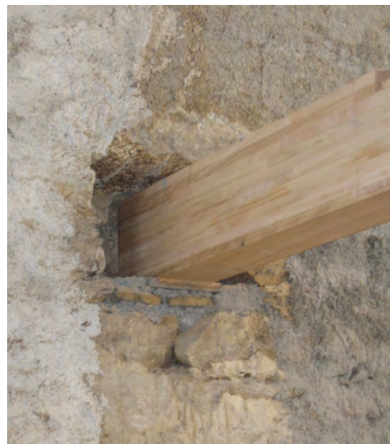
detalle de caja en el muro para apoyo de una viga
