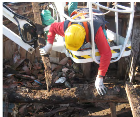
dado el mal estado estado de la cubierta los operarios tuvieron que trabajar desde la barquilla de una grúa
