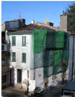
edificio en desuso
