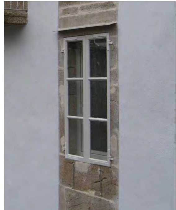
la ventana tradicional enrasada se mantiene como carpintería exterior dentro de un sistema de varias hojas
