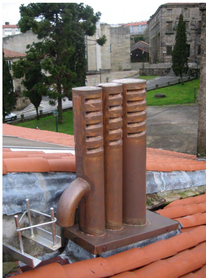
las chimeneas siempre son un punto delicado de la cubierta
