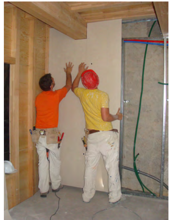
la tabiquería se resuelve en cartón-yeso
