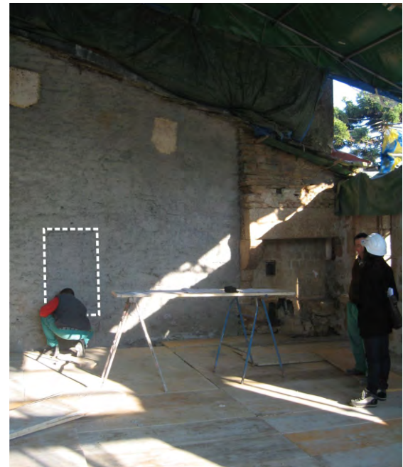
impronta de las ventanas que abrían a las medianeras
