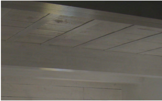
falso techo entablado
