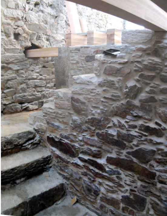
la escalera de acceso al sótano desde la vivienda en planta baja fue una decisión de obra
