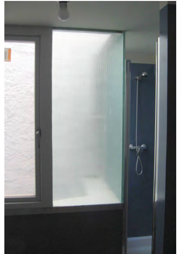
cerramiento del baño mediante losa de vidrio
