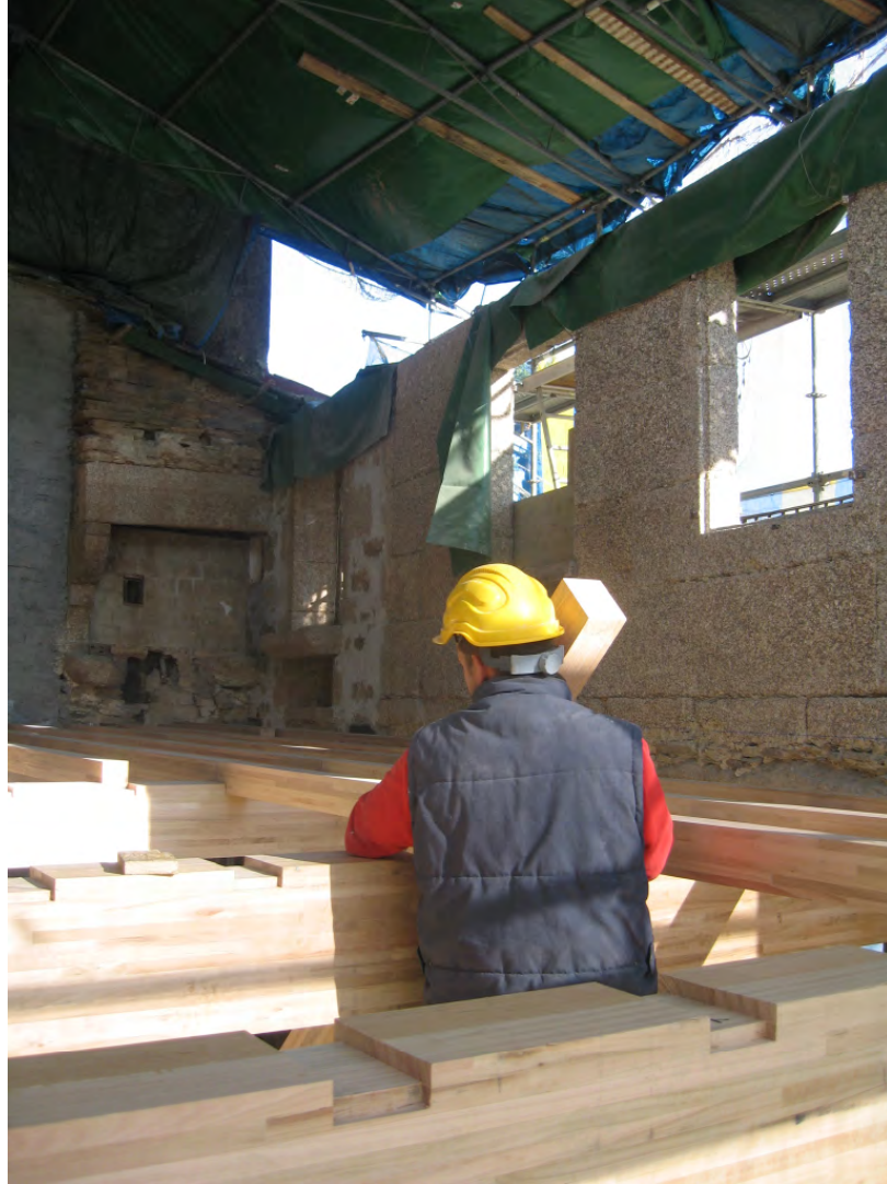
detalle de mecanizado de las vigas para el encaje de los pontones
