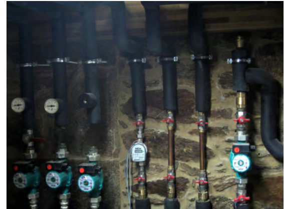
instalación centralizada de producción de ACS y calefacción
