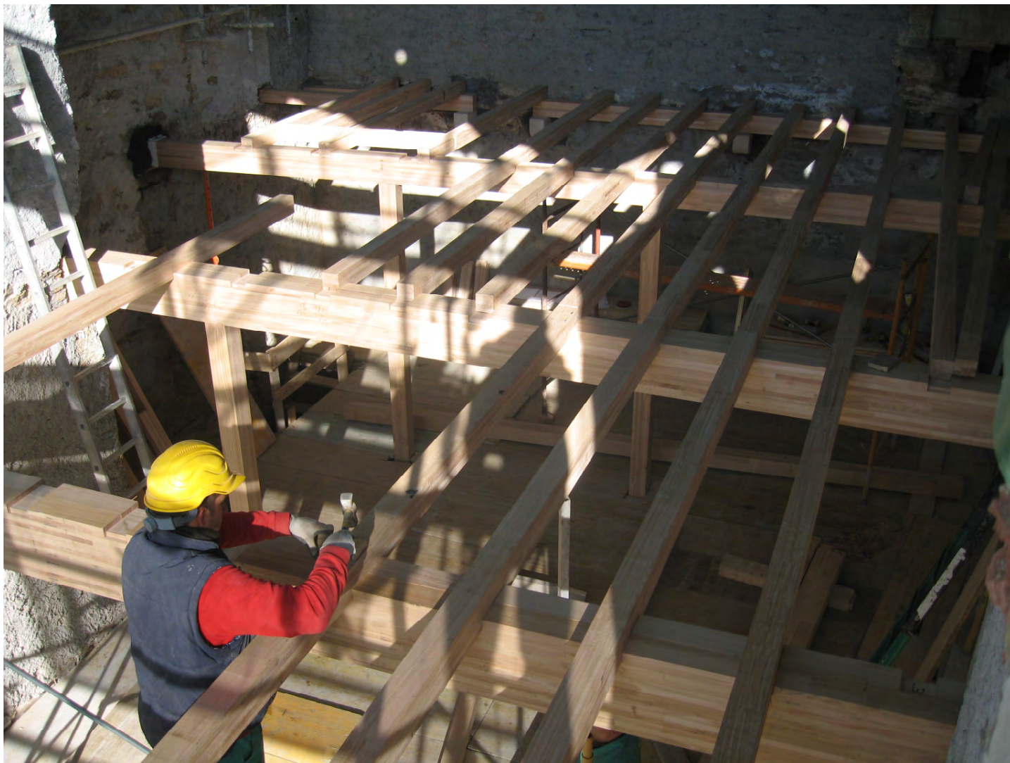
ejecución de la estructura de eucalipto laminado
