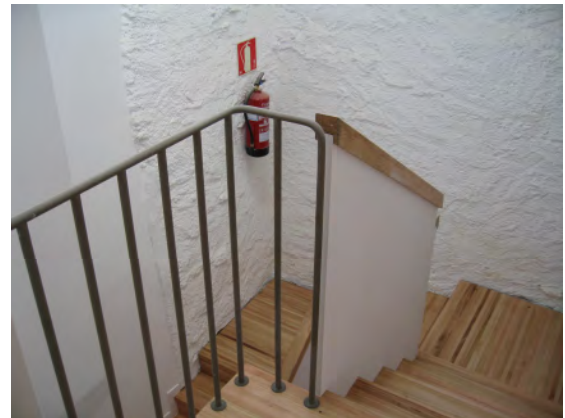
la nueva escalera se coloca en la posición de la original y sigue el mismo desarrollo que esta
