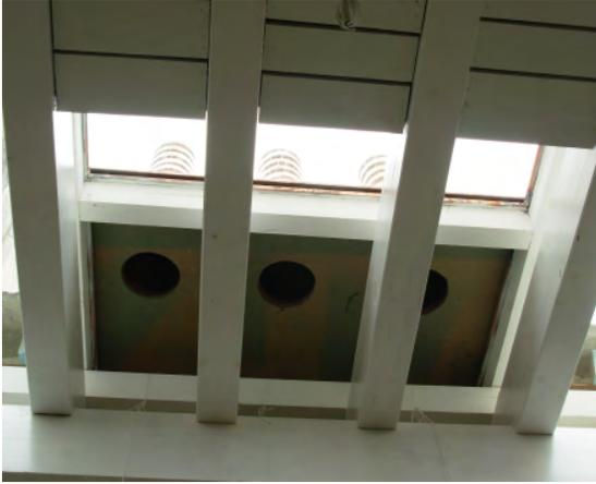
*detalle de la salida de los conductos de ventilación a cubierta*
