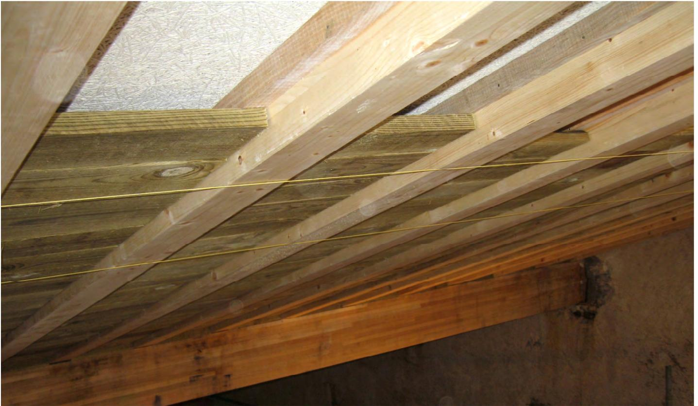
*detalle de la cubierta mediante panel sandwich colocado entre los propios cabios*
