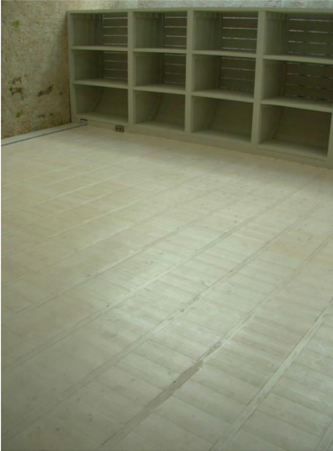
*detalle de la colocación de la tabla entre los pontones del forjado de la consigna*
