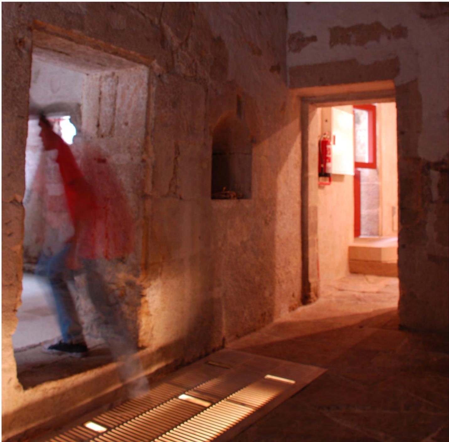
de la colocación de una chapa circular perforada a modo de arqueta registrable en la que también se introduce iluminación.
