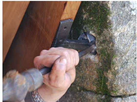
*el proceso de retacado con plomo de los anclajes*
