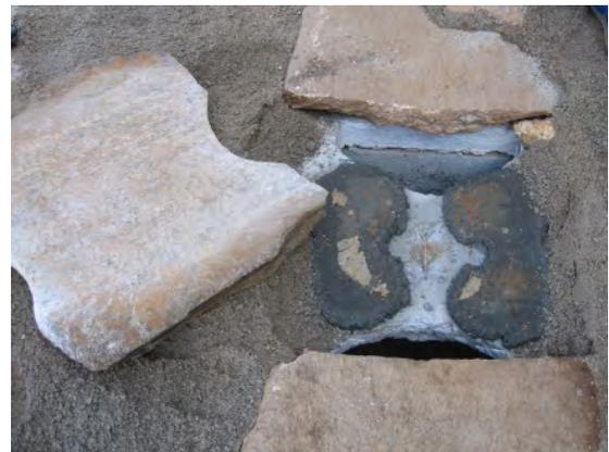
*ejecución del canal lateral bajo el que se lleva la red de pluviales y detalle de punto de recogida de aguas*
