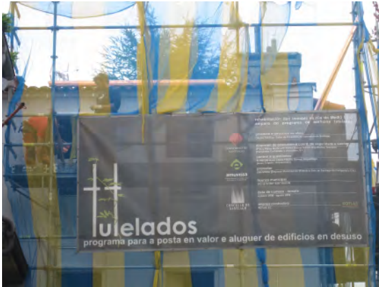
el Programa de Edificios Tutelados puede servirnos para realizar un seguimiento completo en el uso de la energía de un inmueble
