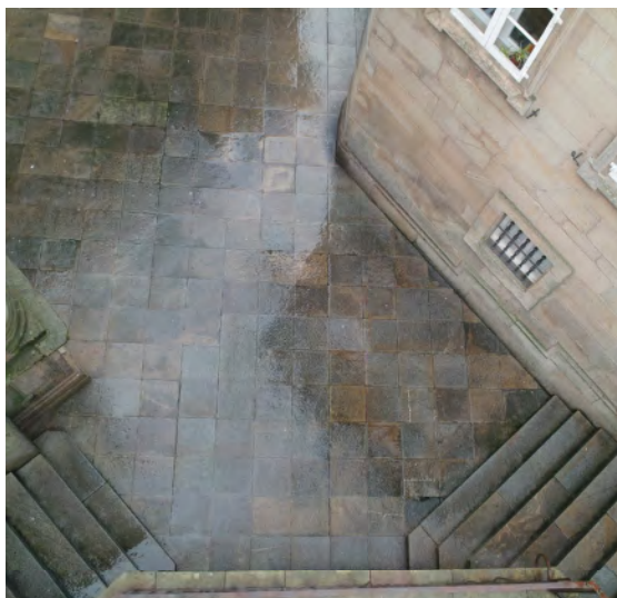
60.000 metros cuadrados de pavimentos históricos que preservar
