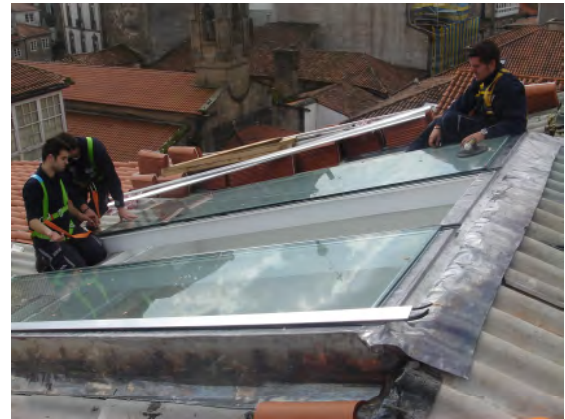
los lucernario ventilados sobre las cajas escalera son elementos fundamentales en la "salud" del edificio
